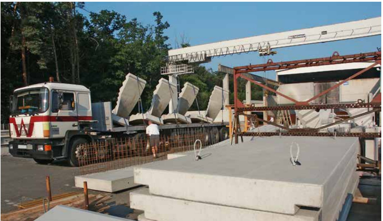
Einsatz der Seilschleife SF im Elementwerk.
