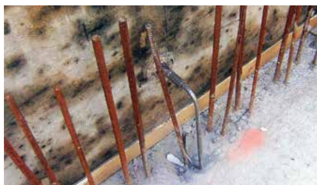
Zuganker im Einsatz auf der Baustelle.
