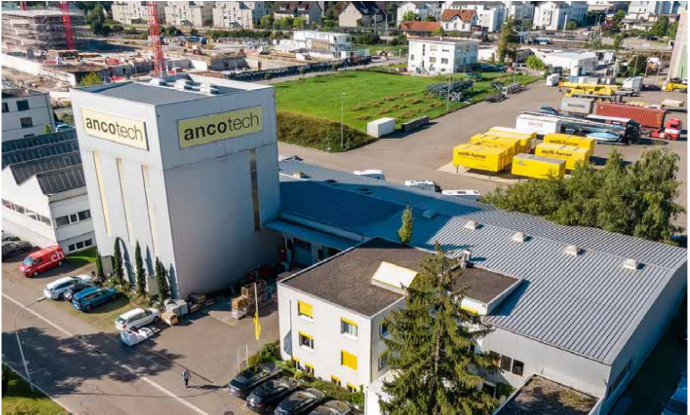
ANCOTECH AG, Produktion und Administration in Dielsdorf/Schweiz
