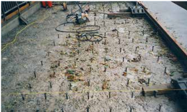
Brückensanierung in Olten Assainissement d'un pont à Olten
